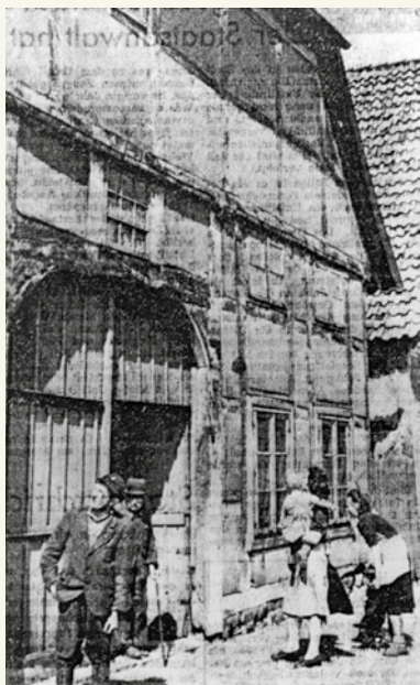
Das Haus der ehemaligen Synagoge vor dem Abriss in den 1950er Jahren
