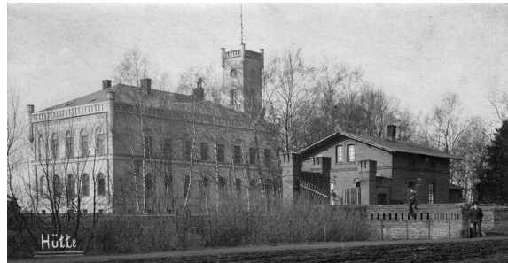
Das Verwaltungsgebäude der ehemaligen Neustädter Hütte, in der im 19. Jahrhundert versucht wurde, mit Torf aus dem Toten Moor Eisen zu schmelzen. Foto: Anfang des 20. Jahrhunderts
